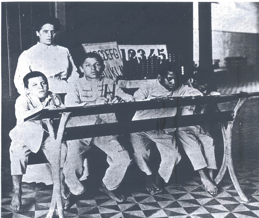
Figura 3: A Escola – Pavilhão Bourneville, 1905
